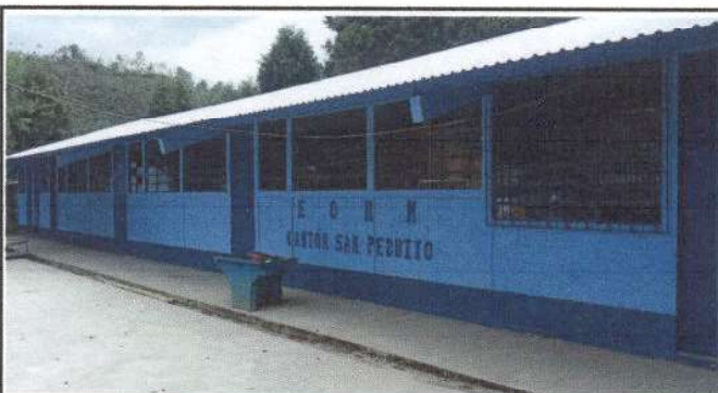
Foto 3: MÓDULO 1 AULAS: PINTURA EN MUROS EXTERIORES E INTERIORES: Pintura en muros exteriores e interiores
