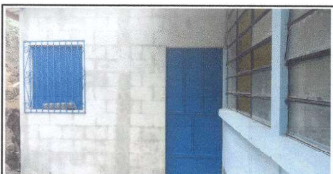
Foto 6: MÓDULO 2 COCINA: PUERTAS DE METAL: Sustitución de chapa.
