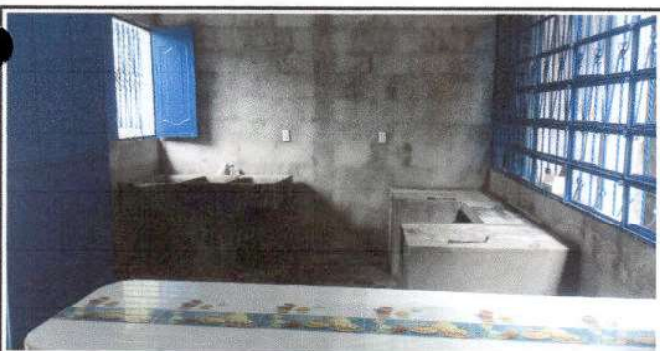
Foto 5: MÓDULO 2 COCINA: PUERTAS DE METAL: Mantenimiento a estructura (lijado, cambio de tubo , cepillado, sujeciones, aplicación de pintura),
