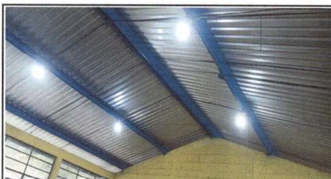
Foto 4: MÓDULO 1 AULAS: REPARACION DE SISTEMA ELÉCTRICO: Sustitución de lamparas tipo LED.
